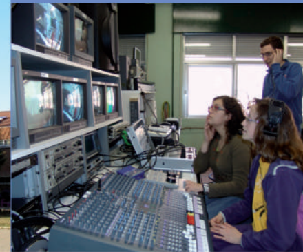
Sistemas de telecomunicación
